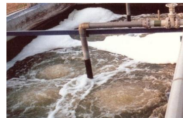
マレーシア ショーラバーゴム手袋製造工場
