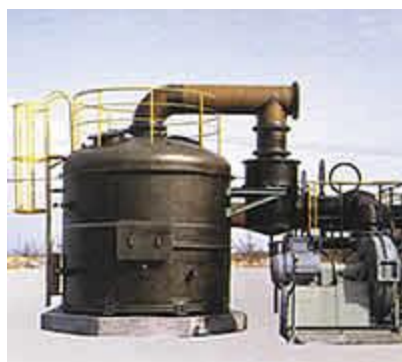
▲排ガス中の水銀除去設備
